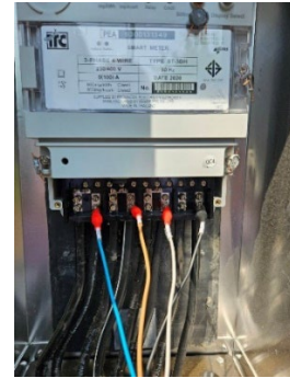
ภาพที่ 12 แสดงการเชื่อมต่อสาย N เข้ากับนิวตรอน และ เชื่อมต่อสายไฟ (L1, L2, L3) เข้ากับระบบไฟฟ้า
