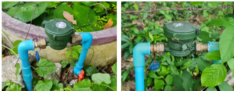
รูปที่ 3.3. การติดตั้ง RFID Tag ไว้กับมิเตอร์น้ำประปา
