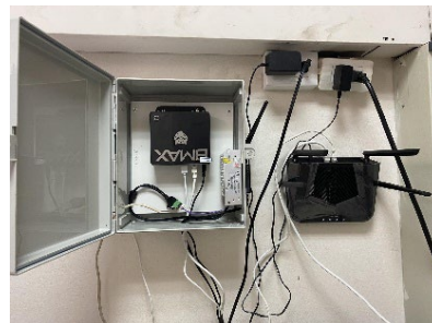
(ข) อุปกรณ์ระบบตรวจติดตามการใช้พลังงานไฟฟ้า
