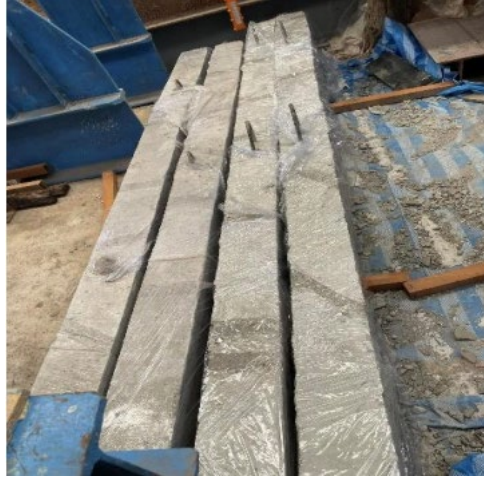
(ง) ปมคานคอนกรีตด้วยพลาสติกใส
