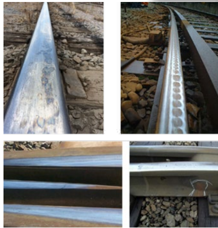
รูปที่ 2 ลักษณะแผลลัดตีนบนสันรางและประแจทางเหล็กบริเวณตะเข้ (frog)
