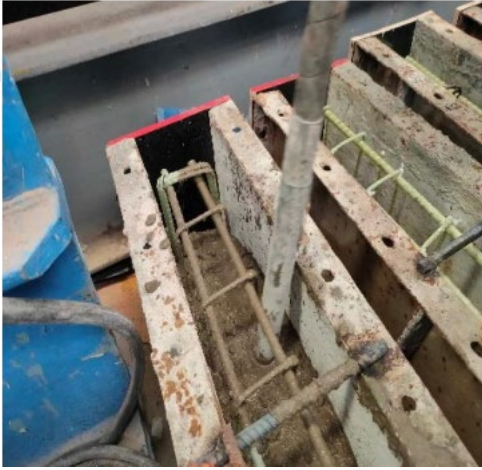
(ค) ใช้เครื่องสั่นคอนกรีต
