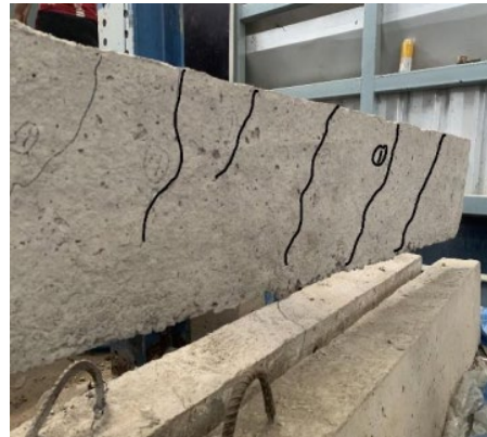
(ข) คานคอนกรีตเสริมแกน DB ปลอก GFRP
