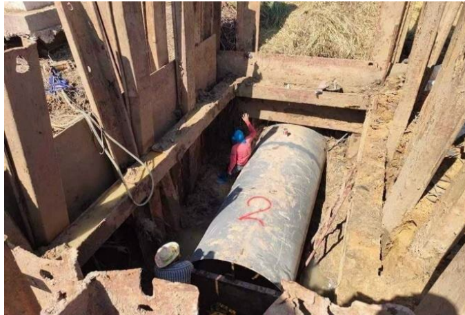
รูปที่ 9 แสดงภาพมุมสูงงานก่อสร้างบ่อตันท่อรอดใต้ดิน
