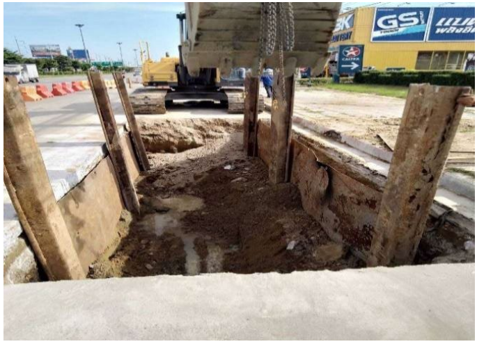
รูปที่ 8 แสดงงานก่อสร้างบ่อดันท่อรอดใต้ดิน
