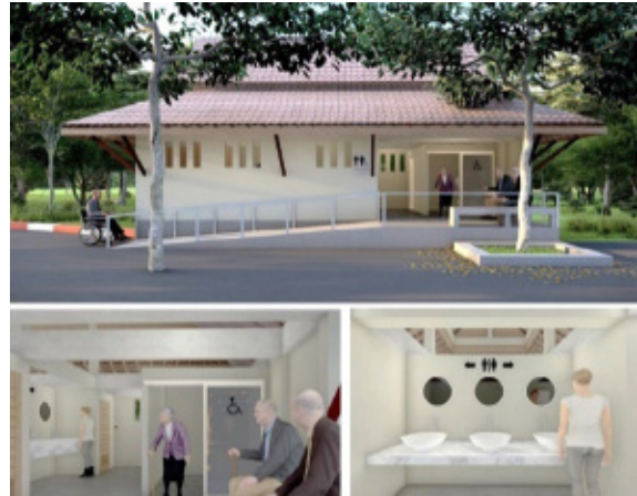
ภาพที่ 10 ทศนิยมภาพการปรับปรุงห้องน้ำกลุ่มที่ 2
