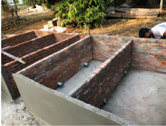
ภาพที่ 2 การก่ออิฐมอดูบ่อเพาะเลี้ยง
