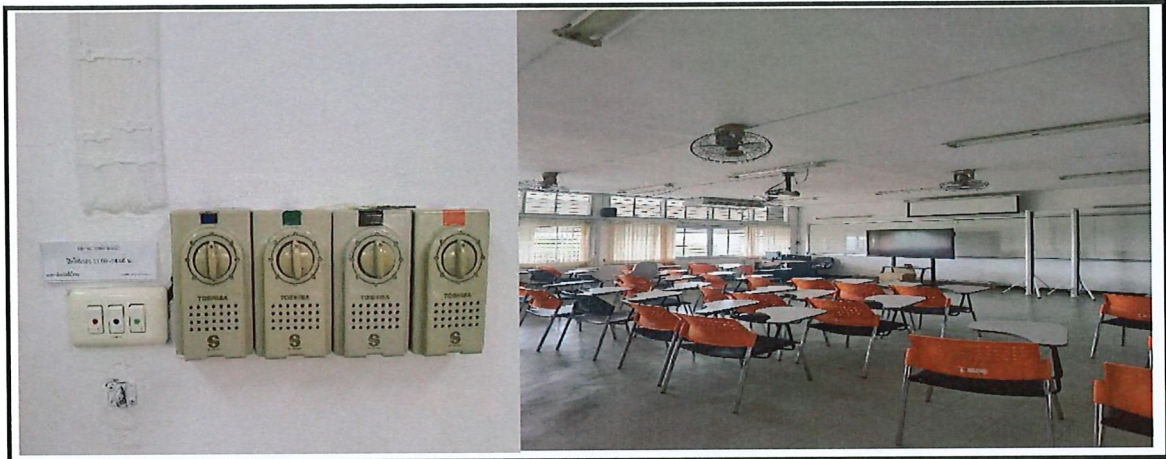
รูปที่ 6-1 หลังดำเนินการปรับปรุง
