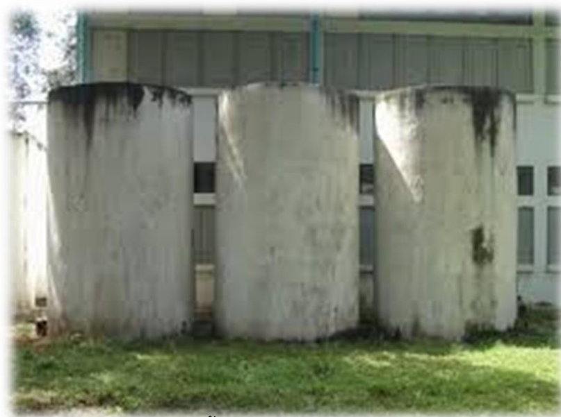
รูปที่ ๔.๕ ถังกักเก็บน้ำไว้ใช้ในอุตสาหกรรมแปรรูปกาแฟ
